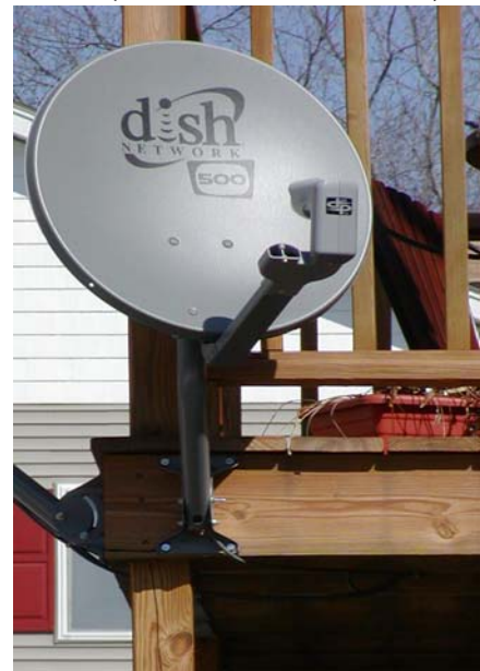
Correct (all wires hidden)
